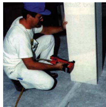
Fixation des plaques Knauf Fireboard avec une agrafeuse pneumatique 10/40 P1
